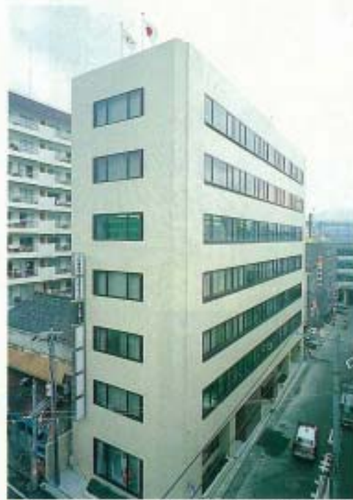
▲中国民航駐長崎弁事処(4F)が設置された松蔭商事本社ビル
