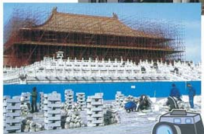
太和殿修復工事中
